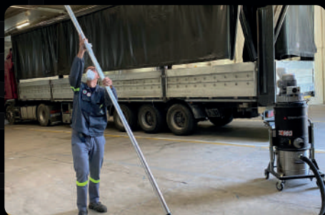
Limpieza en altura
